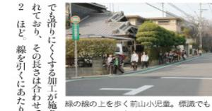
実際の走行してみると、両側に線が引かれている道もあり、よく目を引く。緑の線には雨の日でも滑りやすくする加工が施されており、その長さは合わせて2ほど、線を引くにあたり、路帯帯を広く取り、車道部分を狭く見せることで車の速度を下げる工夫もなされている。今後は他校の通学路でも同様の事業を行っていくという。
