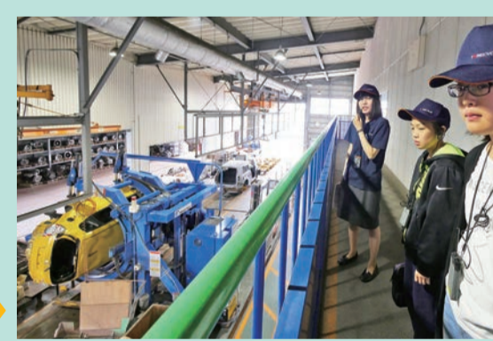
オーディオや内装を外したあとに、車両反転装置で裏側を出してから、駆動系を解体し、燃料タンクを回収。
