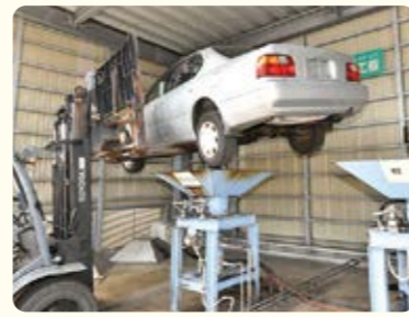
▲ガソリンの抜き取りは車の下に開けた穴から
