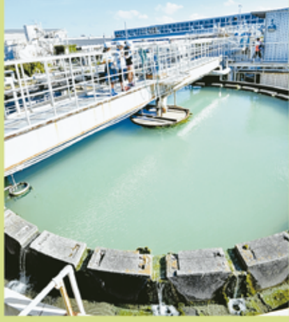
水を浄化するために追浜工場内にある沈殿槽
