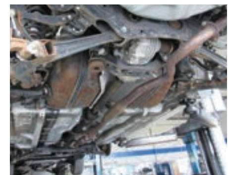
▲全体がさびだらけになってしまうと、修理できないことも...
