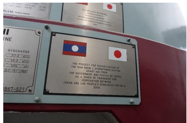
1 号機に取り付けられたラオス・日本のプレート
