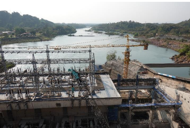
6 号機拡張工事の現場①
