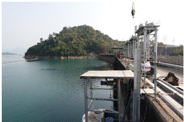
6 号機拡張工事の現場②
