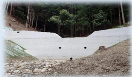
土砂災害防止施設（治山ダム）の整備
