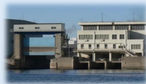
水門・排水機場の改修整備
