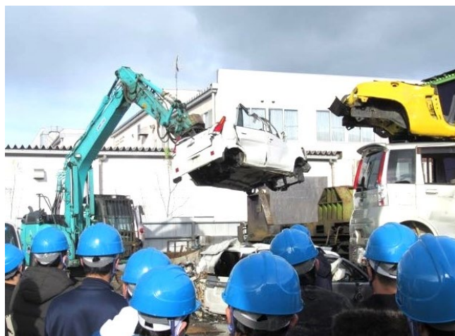
重機を使った解体を見学
