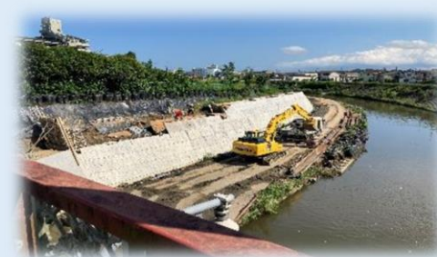
河道拡幅・護岸整備
