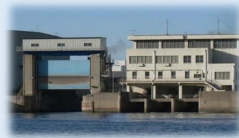
水門・排水機場の改修整備
