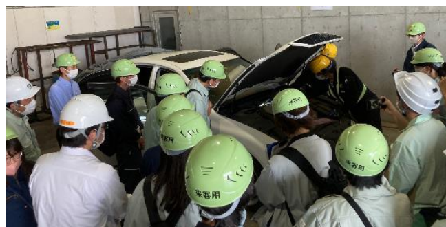
実際の解体現場で適正処理を学ぶ自治体担当者
